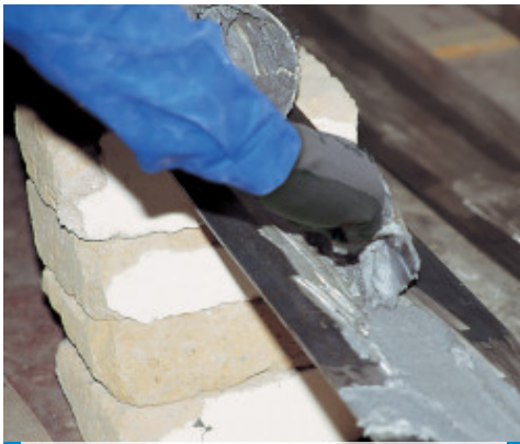
Aplicación de Adesilex PG1 sobre placa metálica
