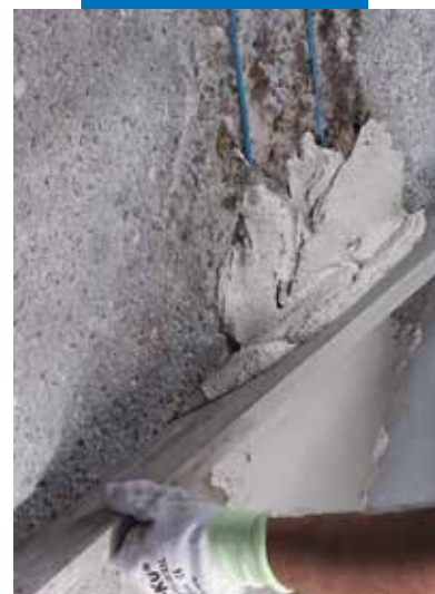
Regleado de Planitop Rasa & Ripara
