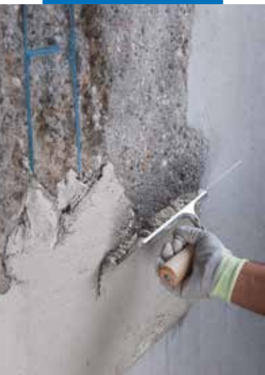
Aplicación con llana de Planitop Rasa & Ripara
