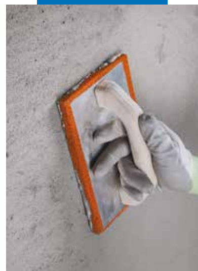
Fratasado de Planitop Rasa & Ripara
