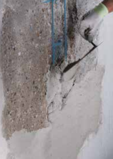
Aplicación con paleta de Planitop Rasa & Ripara
