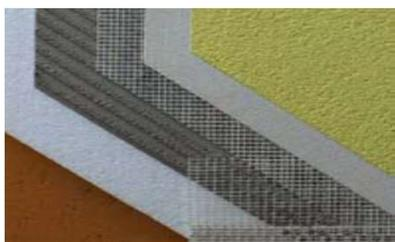
Malla de fibra de vidrio indicada para el refuerzo de morteros en Sistema de Aislamiento Térmico Exterior (SATE - ETICS). Certificado conforme a la norma ETAG 004.
